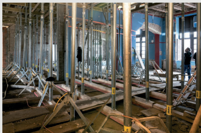
Ich glaub, ich steh im Wald: Der Sprießenwald im Erdgeschoss trägt die Schalung für die neue Stahlbetondecke.
