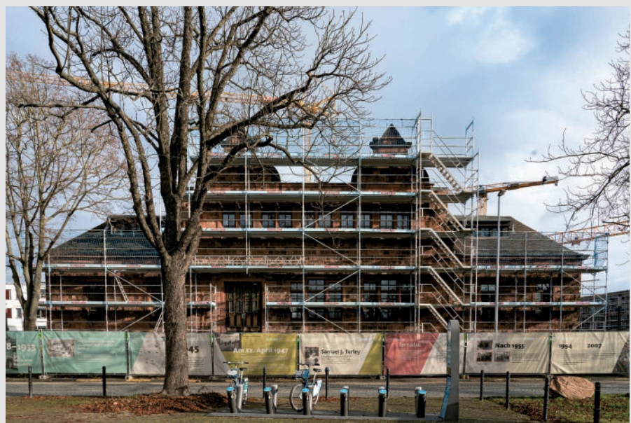
Blick auf das eingerüstete Casino. Sowohl für die Arbeiten an der Fassade, als auch für die im Innenbereich ist das Gerüst nicht wegzudenken.
