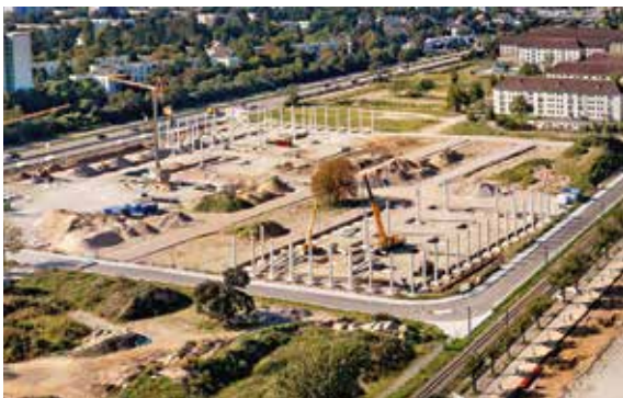
Auf Columbus haben die Rohbauarbeiten am BAUHAUS-Fachmarktzentrum begonnen.
