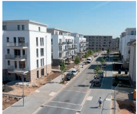
Die Franklin-D.-Roosevelt-Straße nach ihrer Fertigstellung.
