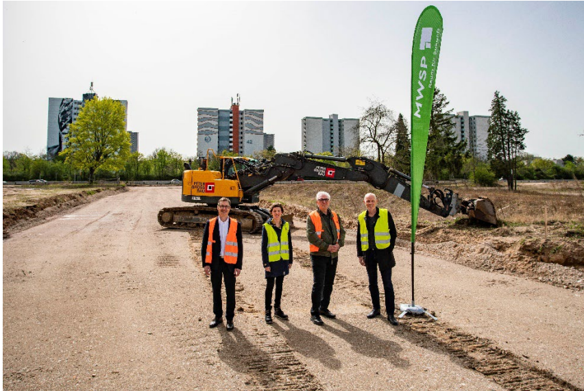
Beginn der Erschließungsarbeiten Columbus (v.l.n.r. Bürgermeister Ralf Eisenhauer, Irina Rabenseifner, Projektleitung Erschließung Columbus MWSP, Reinhold Götze, Stadtrat und Mitglied im Aufsichtsrat MWSP, MWSP-Geschäftsführer Achim Judt) © MWSP/Nikola Neven Haubner
