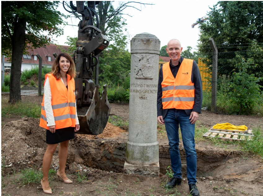
Einsetzung des Jubiläumsgrenzsteins auf TAYLOR gemeinsam mit Dr. Lisa Ronellenfitsch, Leiterin des Fachbereichs Baurecht, Bauverwaltung und Denkmalschutz (links), MWSP-Geschäftsführer Achim Judt (rechts) © MWSP/Annette Mück
